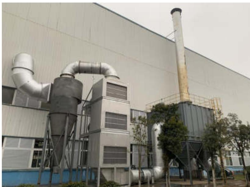
熔化线冷却系统和布袋除尘器现场照片
