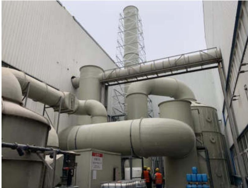
有机冷芯线三乙胺净化喷淋塔现场照片
