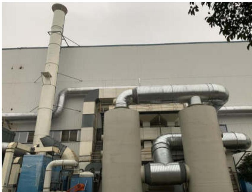
有机热芯线碱液喷淋塔+活性炭吸附-浓缩+RCO 催化燃烧现场照片
